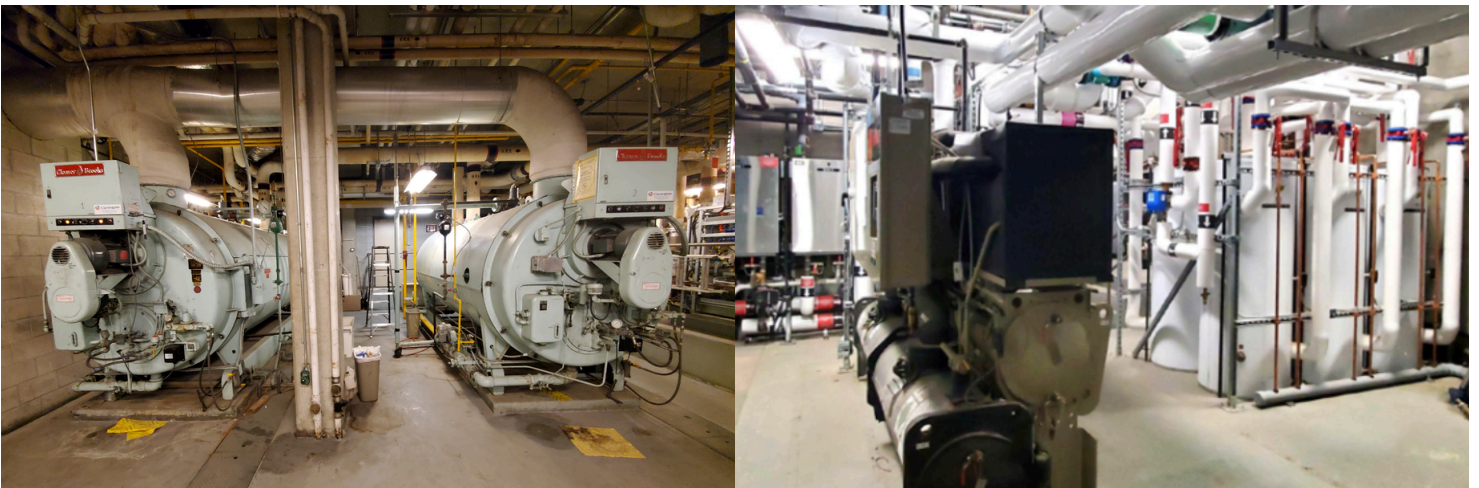
Image 3 (à gauche) : Deux chaudières Cleaver Brooks (avant la modernisation). Source : Ben Mills, Impact Engineering (2).
