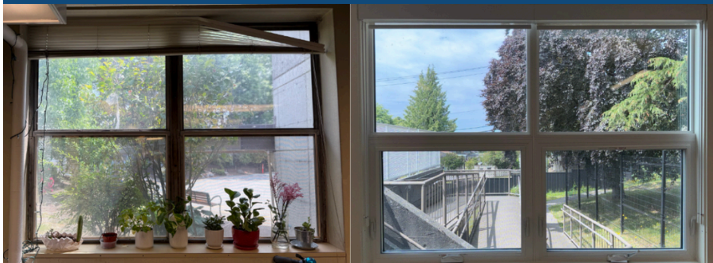
Image 7 (à gauche) : Fenêtres d'origine à simple vitrage de 1954, avant le remplacement. Image 8 (à droite) : Nouvelles fenêtres triple vitrage de la série Silex 2100. Source : George Gemmel, Providence Health Care (2).
