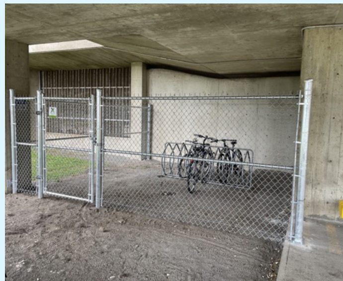
Légende : Stationnement à vélos protégé contre le vol, adjacent au stationnement à vélos existant devant l'entrée principale de l'Institut. L'accès à la recharge électrique sera bientôt disponible.
